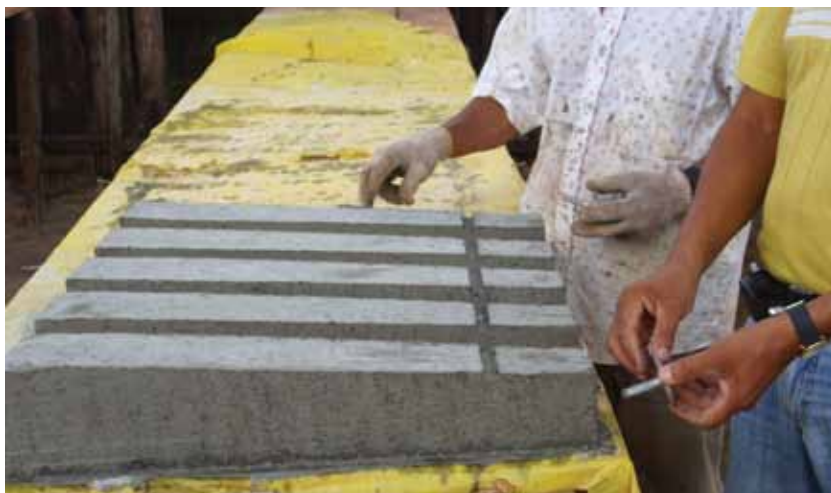
Confecção dos Marcos de Concreto
